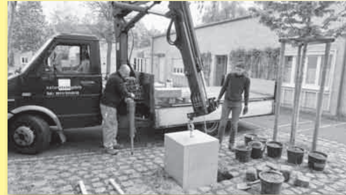
Einhebung des Fundaments am 3. Mai
